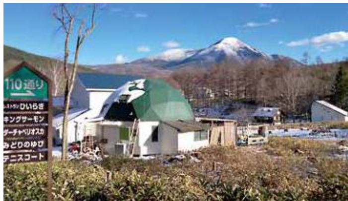
令和6年度 102通り周辺伐採事業完了後
