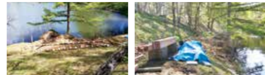
令和7年ウッドデッキ基礎配置中
