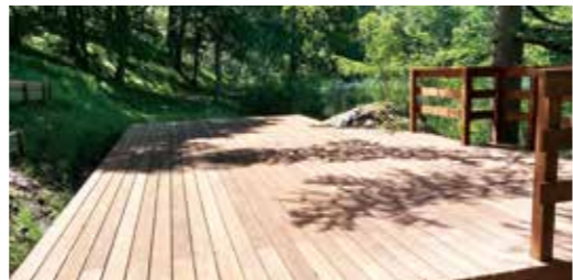
完成したウッドデッキ
